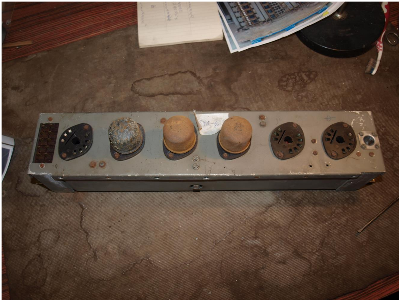
Modul SY1-6, 6P před renovací
