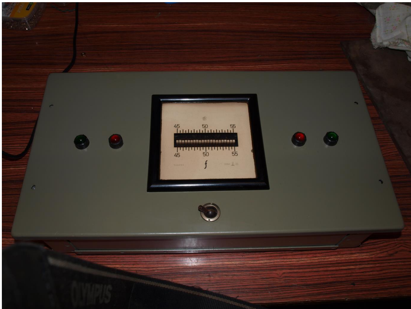
Modul SY2-1 po renovaci
