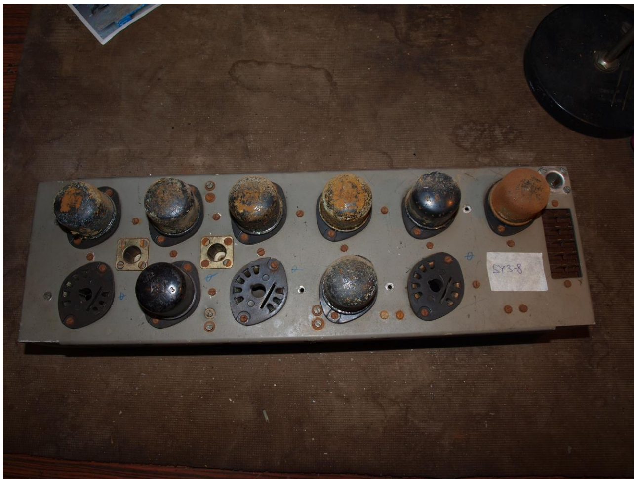
Modul SY3-8, 8L před renovací
