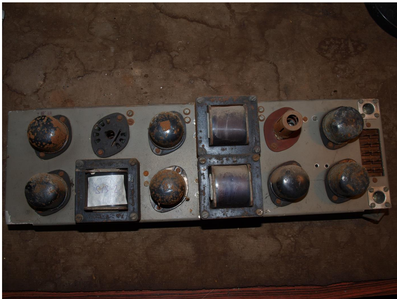
Modul SY3-2, 2L před renovací
