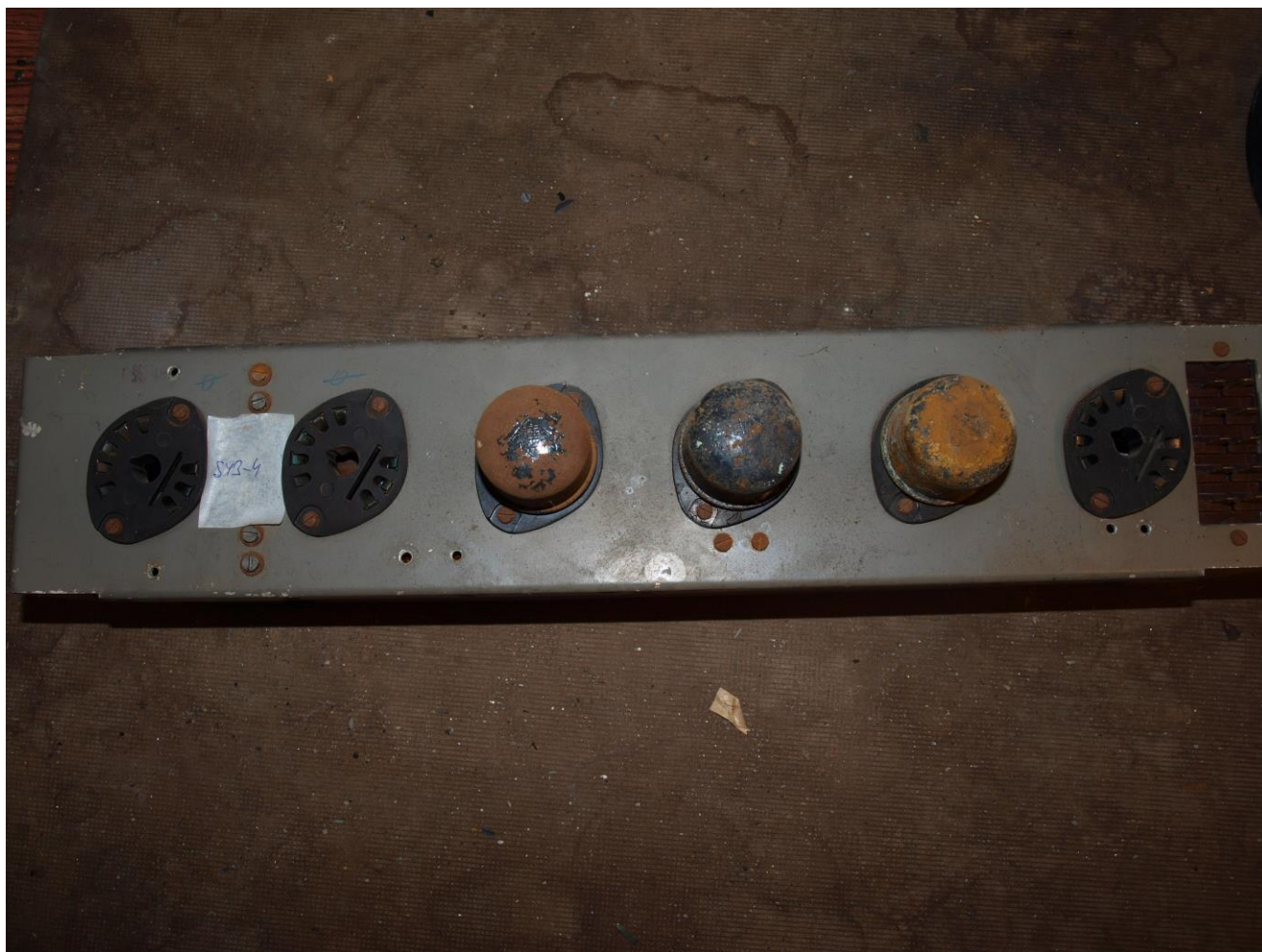
Modul SY3-4, 4L před renovací
